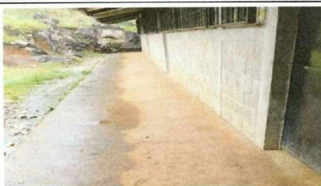
Foto 2: Colocacion de vidrios y balcon del Centro Educativo en la parte frontal del modulo.
