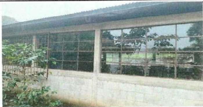
Foto1: Aplicación de pintura en muro interior y exterior del Establecimiento.
