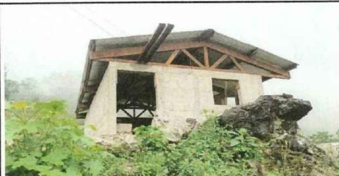
Foto 6: mantenimiento a las costaneras y cambio de laminas galvanizadas por laminas troqueladas.
