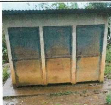
Foto 4: sustitucion de laminas galvanizadas a laminas troqueladas del baño, remodelacion de puertas y chapas, pintura en el muro interior y exterior.
