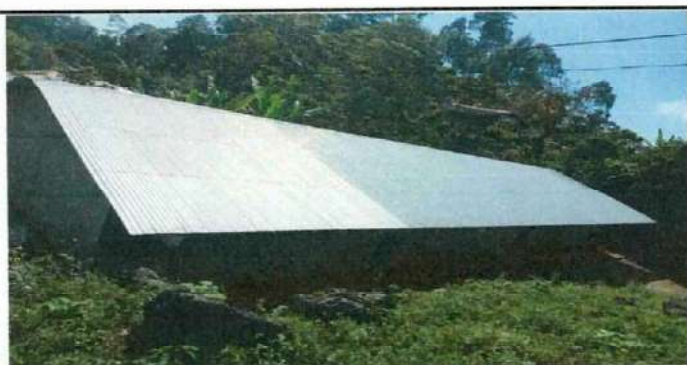
Foto 5: cambio de laminas galvanizadas por láminas troqueladas del Centro educativo.
