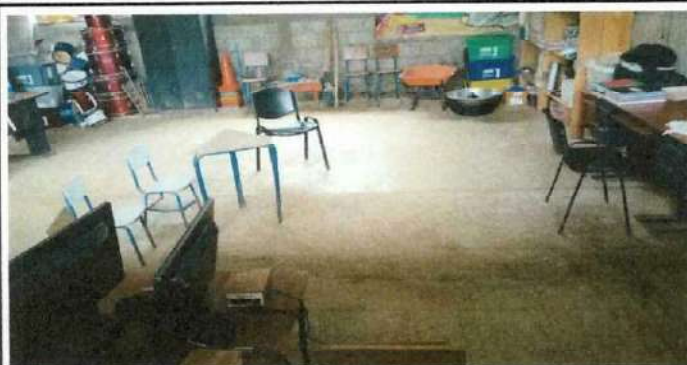
Foto 3: Ampliacion del piso del Centro Educativo y alisado.
